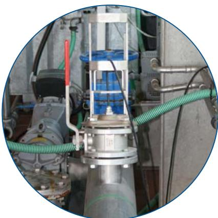
Fig. 3: SOLITAX highline sc en tubería
